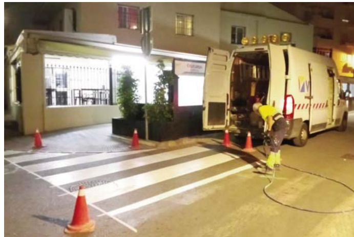
Distintas actuaciones de mantenimiento y desbroce. VIVA
