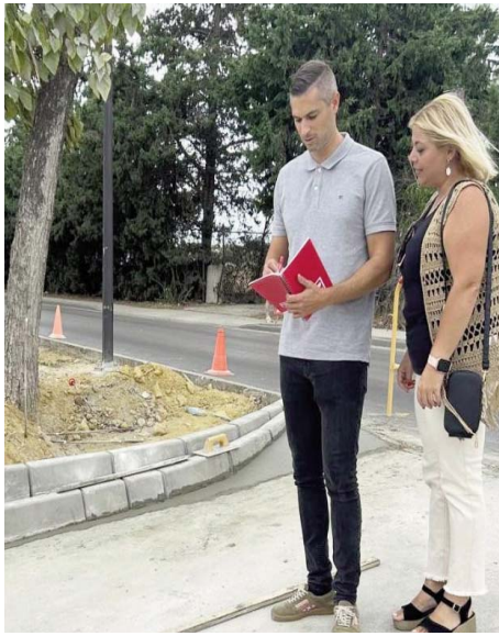
Visita a las obras. VIVA
