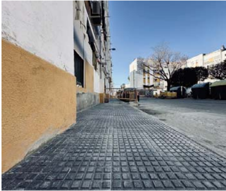
Los trabajos incluyen la renovación y ampliación de los acerados. VIVA
